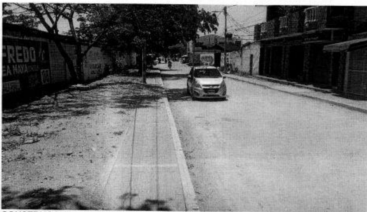
CONSTRUCCION DE PAVIMENTO Y ANDENES
